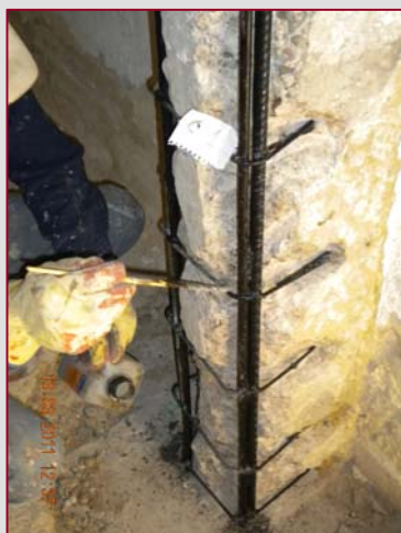
Pasivación de armaduras
