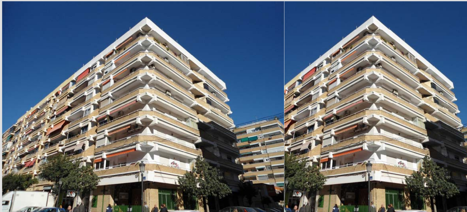
Rehabilitación Fachada CI J. Ramon Jimenez (Valencia) en fase de ejecución
