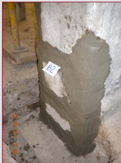
Mortero de reparación
