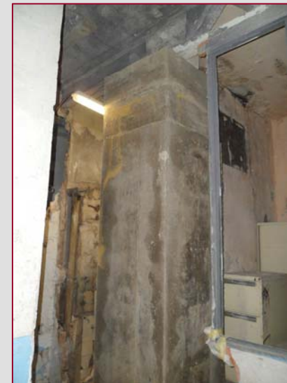
Vertido, compactación y curado del hormigón de refuerzo.
