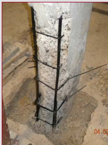
Pasivación de armaduras
