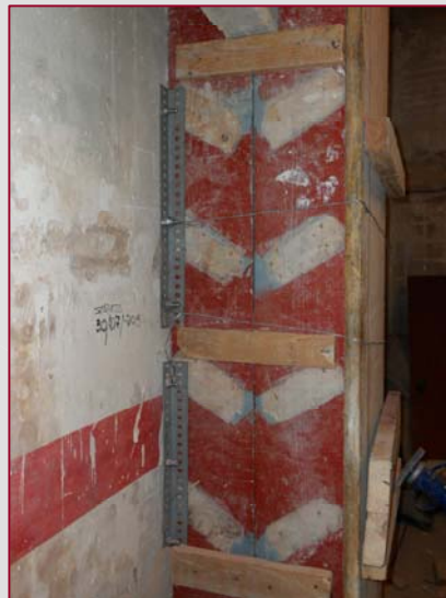
Encofrado con tableros de madera. Disposición de separadores en las armaduras respecto a los pilares existentes y al encofrado, para mantener los recubrimientos adecuados.
