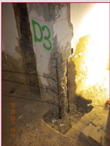
Limpieza y saneado de la zona
