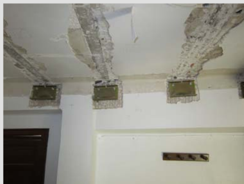
Picado Yeso y colocacion de cartelas
