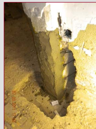
Mortero de reparación
