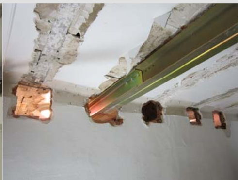
Colocacion de Viga de Refuerzo
