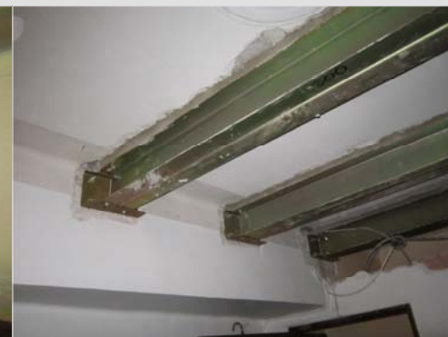
Retacado Vigas MVH con Forjado
