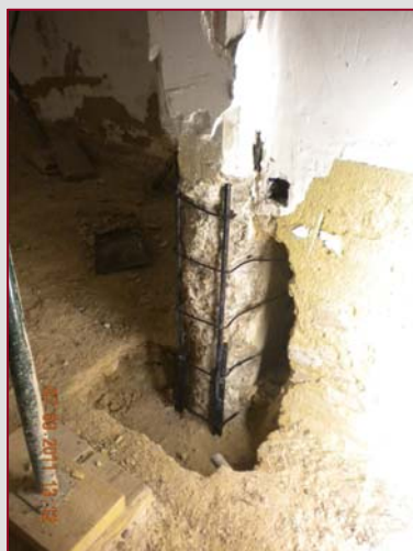
Pasivación de armaduras
