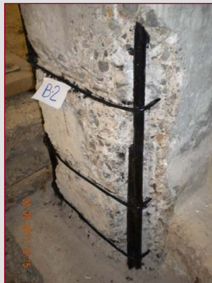
Pasivación de armaduras
