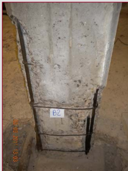
Limpieza y saneado de la zona
