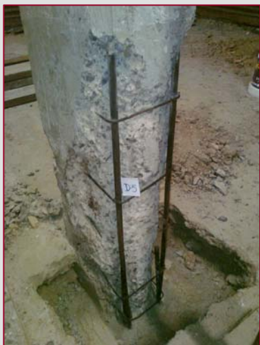
Limpieza y saneado de la zona
