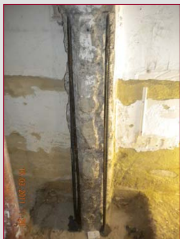
Limpieza y saneado de la zona
