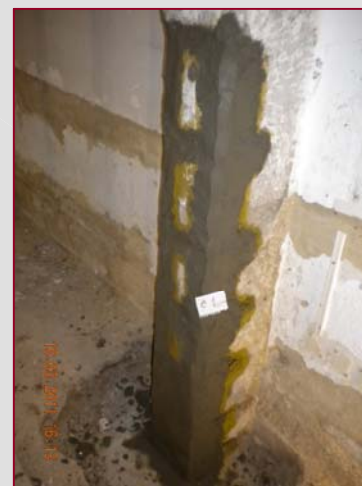
Mortero de reparación
