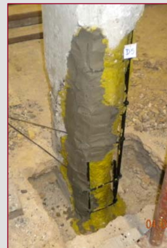
Mortero de reparación
